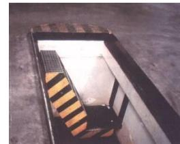
La position du véhicule ne doit pas obstruer les moyens d'accès à la fosse.
